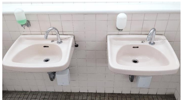
大船駅駅トイレ自動水栓化
