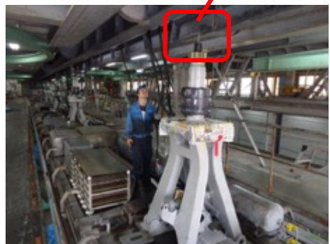
27年間台車と車体を締結していたボルト
