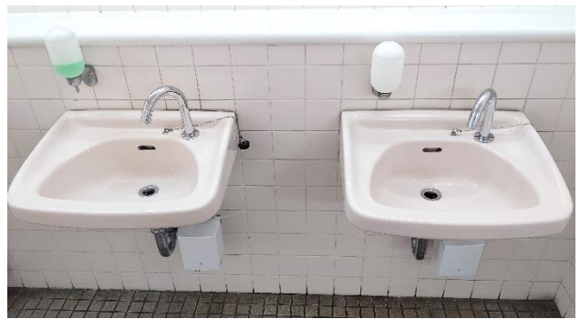
大船駅駅トイレ自動水栓化
