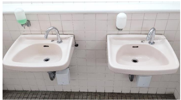
大船駅駅トイレ自動水栓化
