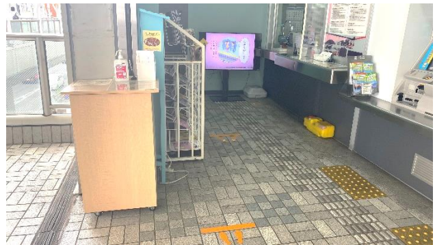
駅窓口アルコール消毒液を設置
