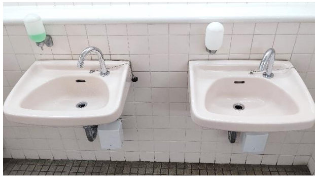
大船駅駅トイレ自動水栓化
