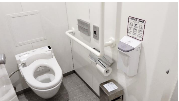
駅トイレ便座シートクリーナー設置
