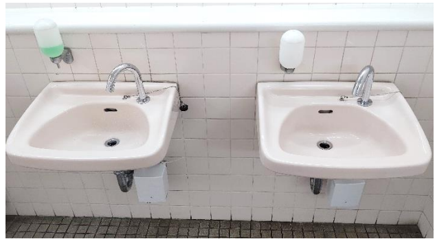
大船駅駅トイレ自動水栓化
