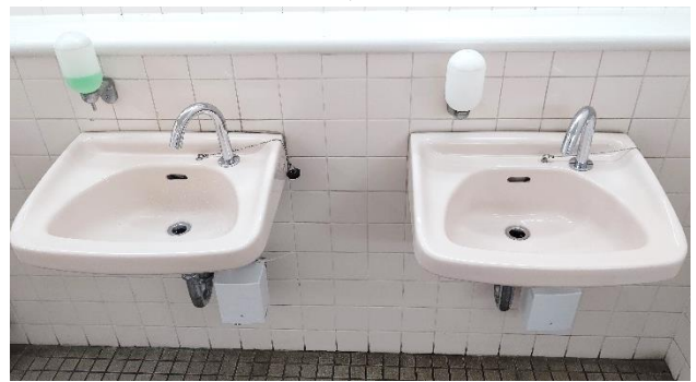
大船駅駅トイレ自動水栓化
