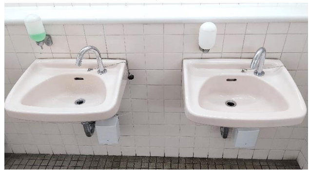
大船駅駅トイレ自動水栓化
