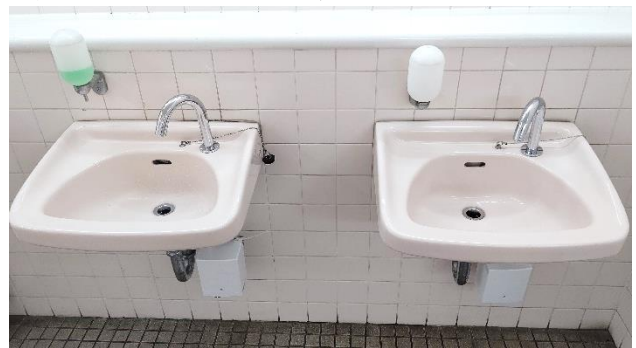
大船駅駅トイレ自動水栓化
