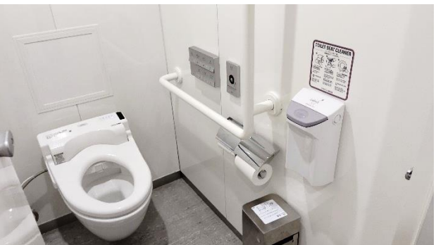
駅トイレ便座シートクリーナー設置
