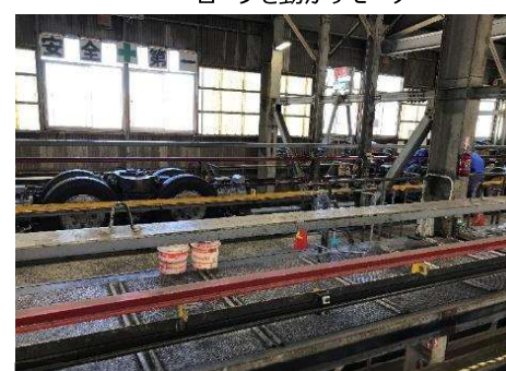
湘南モノレール深沢車両基地
