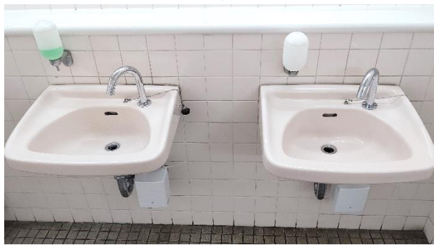
大船駅駅トイレ自動水栓化
