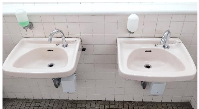
大船駅駅トイレ自動水栓化
