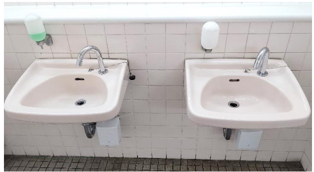
大船駅駅トイレ自動水栓化
