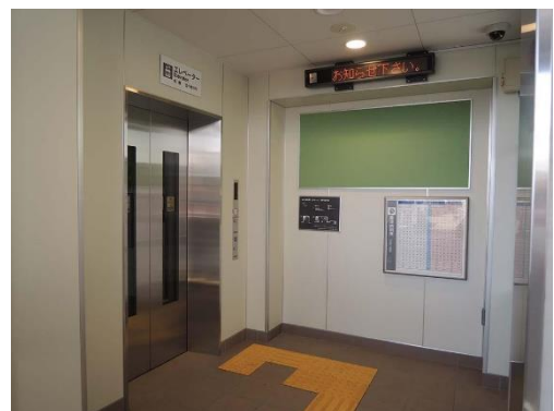
上りエレベーター
